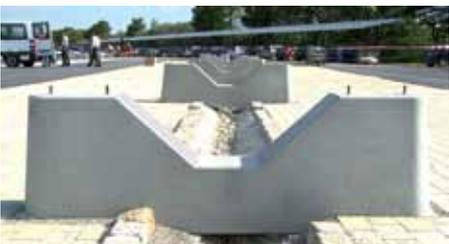
Fertigteile Fundament gesetzt und ausnivelliert
