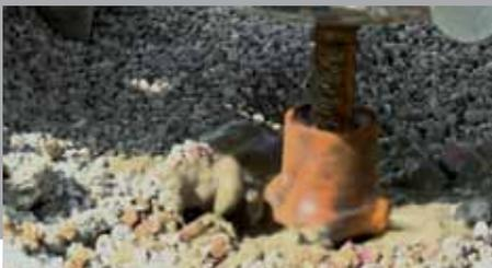
Austritt von Zementmörtel durch Kreuzbohrkrone
